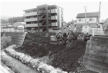
増水すると、並柳方面の水路から流れる雨水が排水できくなり、床下浸水に繋がる恐れがあります。この施設は、流れてくる雨水をポンプで吸い上げて田川に向かって放水するためにつくられています。
